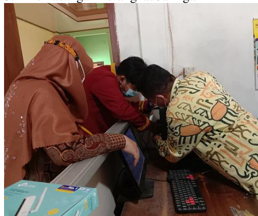
Gambar 8 Pemasangan Perangkat Jaringan
