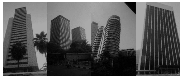
Gambar 2. Gedung Perkantoran di Daerah Jakarta, Indonesia.
