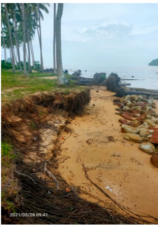
Gambar 6. Foto lokasi abrasi di Pantai Gosong bagian timur
