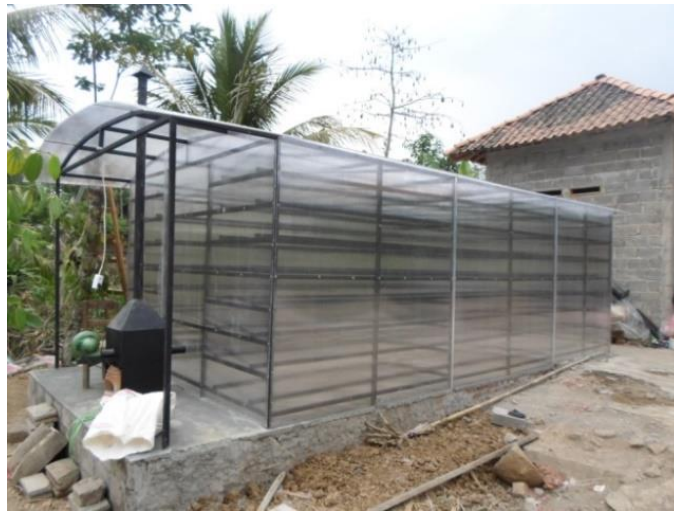
Gambar 6. Implementasi tungku biomassa pada bangunan pengering
