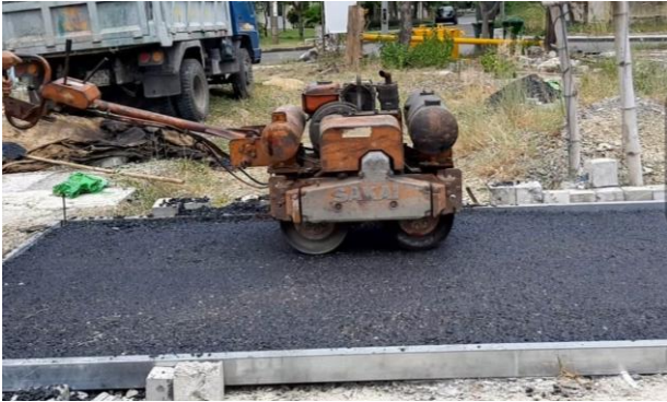
Hình 4. Thi công kết cấu mặt đường mô hình thực nghiệm
