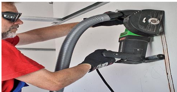
Hình 1. Thao tác cắt rãnh tường thủ công
