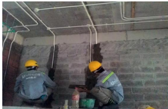
Hình 2. Công đoạn thi công lắp ống âm tường
