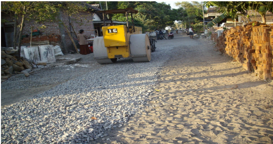
Foto 1. Pembuatan Jalan Desa Gemenggeng oleh Pakdhe Woto
