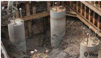
Gambar 16 Pondasi Bore Pile
