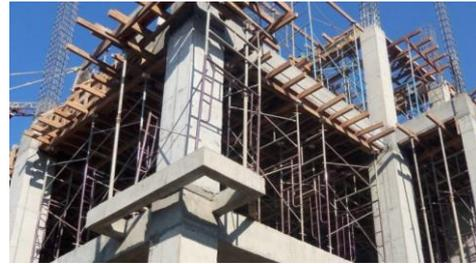
Gambar 18 Kolom & Balok Beton Bertulang
