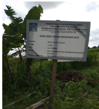
Gambar 4 Papan Informasi Pembangunan Fisik
