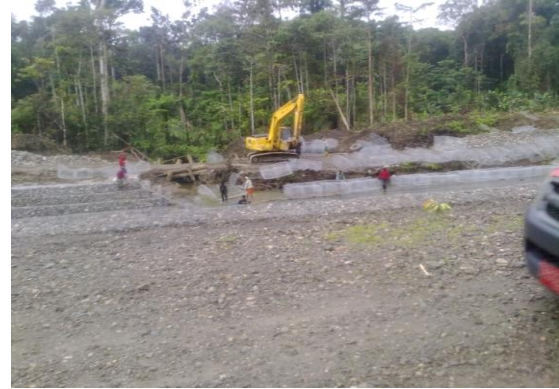
Gambar 6 Pekerjaan normalisasi sudetan Kali Bonto menuju Kali Braza
