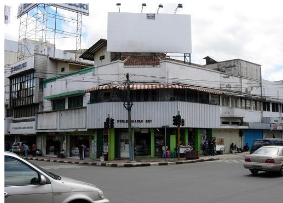
Gambar 30. Sudut jalan Otista – jalan Jend Soedirman, sekarang.
