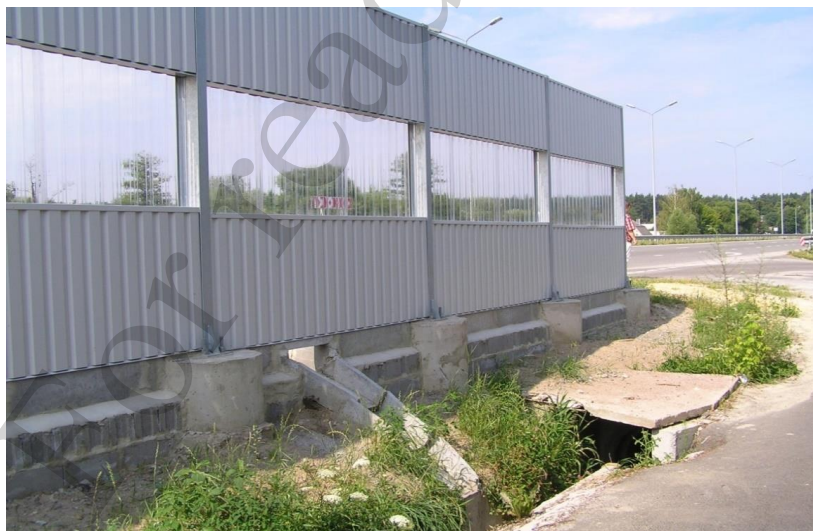
Рис. 4. Водостічний отвір у шумозахисному екрані
