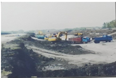
Gambar 3. Pekerjaan Penggalian Tanah Pelurusan Sungai Widas.
