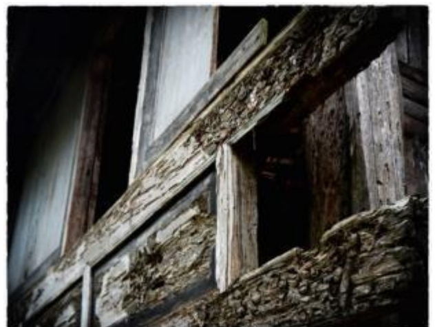
Foto 11. Motif Ragam hias Rumah Gadang yang sudah lapuk (foto, Karya Indah Susanti, 2015)
