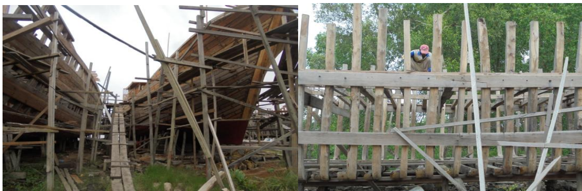
Gambar 3. Aktivitas Pembangunan Kapal
