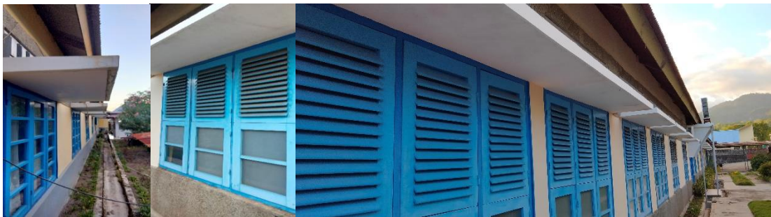
Gambar 3. Jendela ukuran 100x60 cm, pada sisi barat dan timur sebanyak 120 buah Sumber: Dokumen Pribadi, 2021
