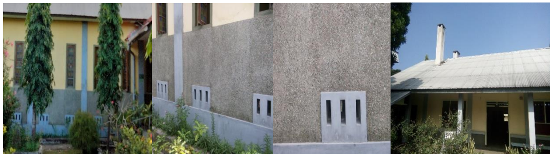
Gambar 7. Ventilasi bawah, arah selatan ukuran 30x15 cm, sebanyak 12 buah dan 2 buah cerobong asap. Sumber: Dokumen Pribadi, 2021
