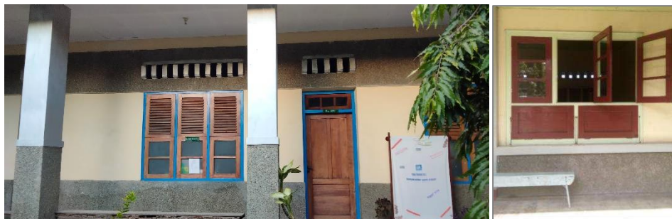
Gambar 4. Jendela ukuran 100x60 cm dan 60x40, arah barat sebanyak 20 buah dan selatan sebanyak 12 buah. Sumber: Dokumen Pribadi, 2021
