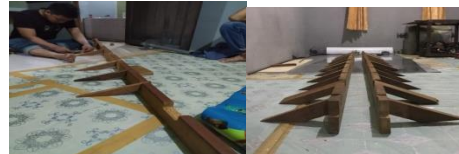
Pembuatan Rangka Speed Bumper Sumber : (Dokumen Pribadi)
