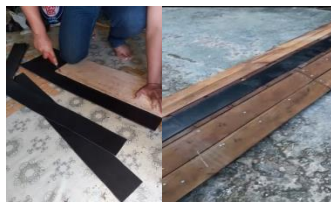
Gambar Proses Pemasangan Karet Selir Sumber : Dokumen Pribadi
