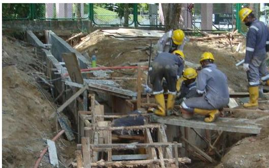
**Gambar 4. Pemasangan saluran U-ditch**
