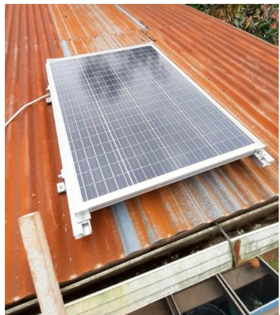
Gambar 6. Pemasangan Panel Surya di Atas Penetasan Telur Itik
