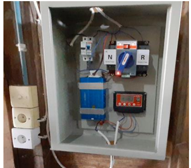
Gambar 5. Pemasangan Box Panel Dengan Peralatan Sistem Hybrid.
