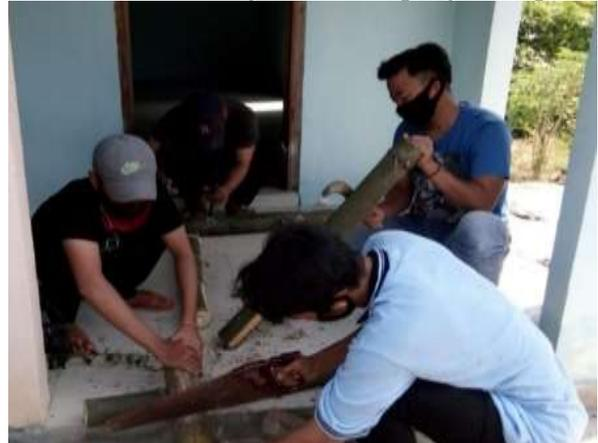
Gambar 6. Proses pemotongan bambu untuk penyangga pada rubuha
