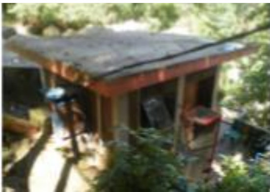
Gambar 12. Rumah Pembangkit PLTMH
