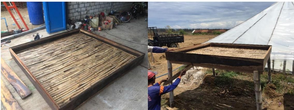
Gambar 5. Kiri : Dinding Pembatas. Kanan : Pemasangan Alat Penopang di Tambak Garam
