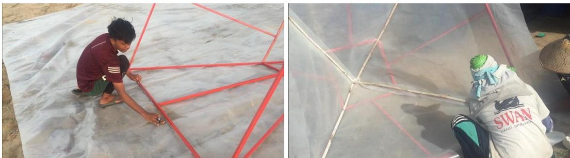
Gambar 7. Kiri : Pematangan *Geo-membrane*. Kanan : Pesangan Kabel Tist
