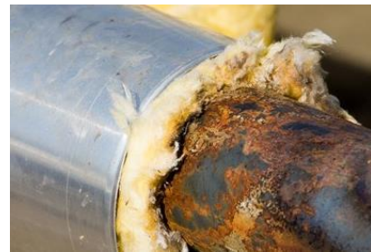
Gambar 1. Korosi pipa dibawah insulasi (CUI)
