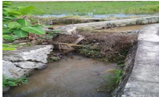
Gambar 3. Kerusakan pada struktur saluran irigasi sekunder (Koordinat : E.120°11'16.30" S. 3° 1'32.50")
