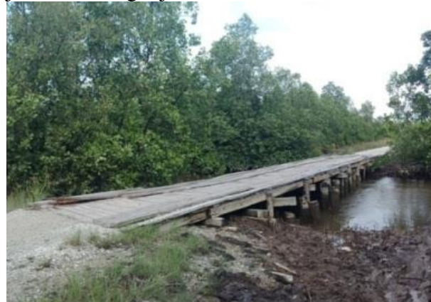
Gambar 1 Kondisi jembatan Sungai Jalan Antara
