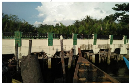
Gambar 1 Kondisi eksisting jembatan
