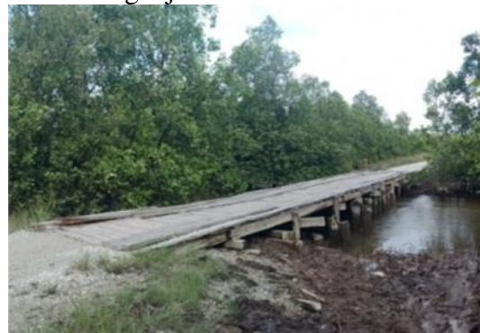
Gambar 1. Kondisi jembatan Sungai Jalan Antara
