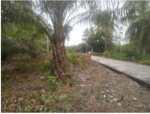
Gambar 7 Kondisi jalan existing pada STA 02+050
