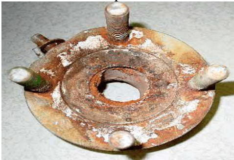
Gambar 5. Korosi pada Valve
