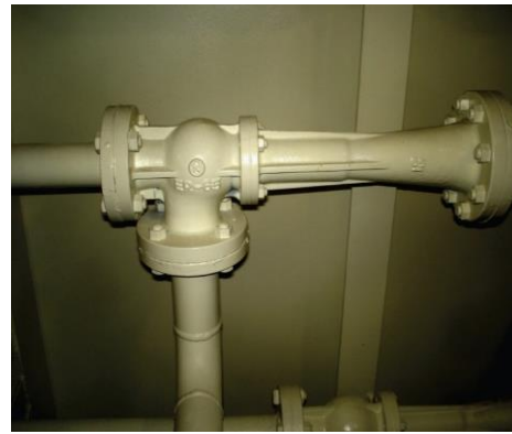
Gambar 6. Penggantian Ejector
