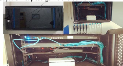
Gambar 4.5 Instalasi Rak Server
