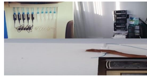
Gambar 4.8 Instalasi Perangkat Access Point
