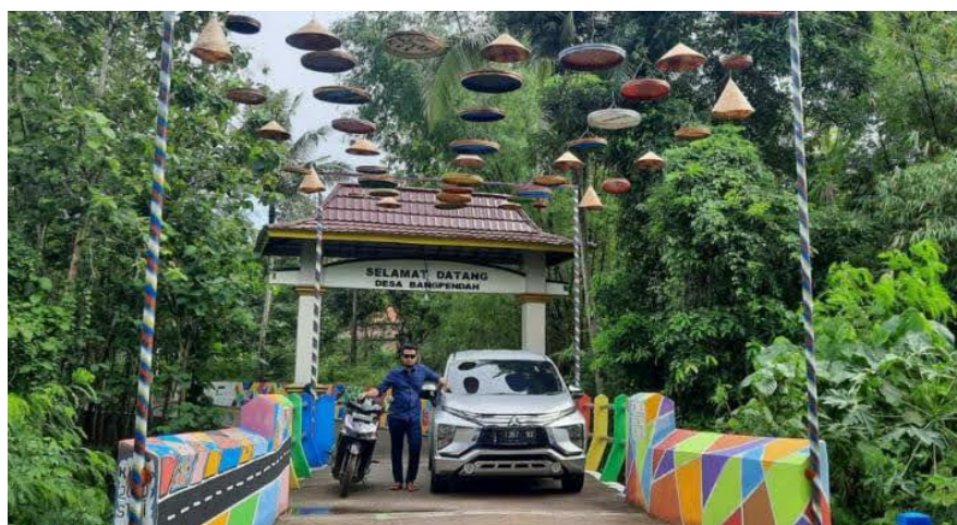
Jembatan Desa sesudah di revitalisasi
