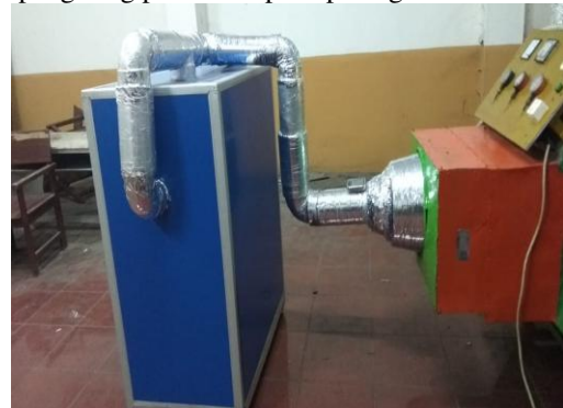
Gambar 3. Pemasangan mesin pengering
