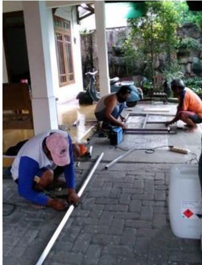
Gambar 3. Proses pengukuran dan pemotongan material
