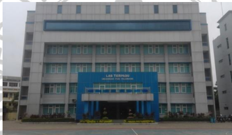
Gambar 2. Gedung Laboratorium Terpadu Universitas PGRI Palembang
