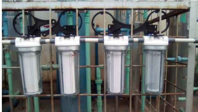
Gambar 2. Rangkaian alat filter membran mikro
