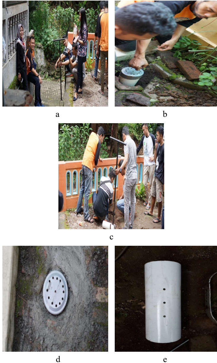
Gambar 3. Pembuatan Lubang Resapan Biopori (LRB)
