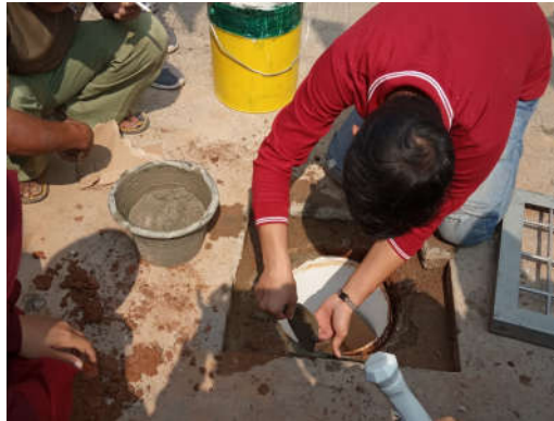
Gambar 3. Pemasangan Ember Pada Lubang Biopori
