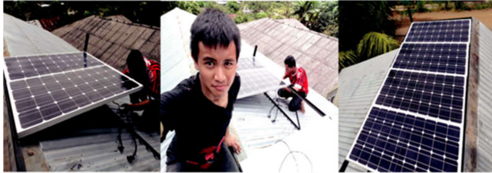
Gambar 4. Pemasangan solar cell di tempat mitra di atas atap
