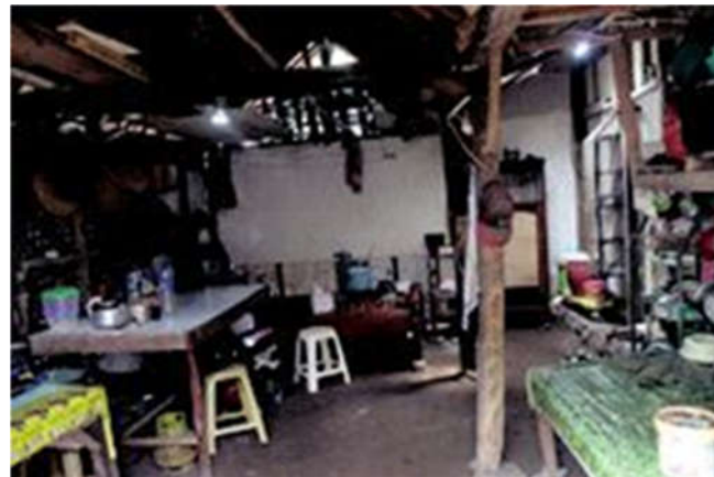
Gambar 14. Pemasangan lampu penerangan dalam rumah Mitra
