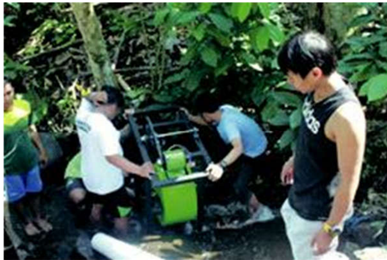
Gambar 9. Proses pemasangan pembangkit listrik tenaga pikohidro di lokasi Mitra (1)
