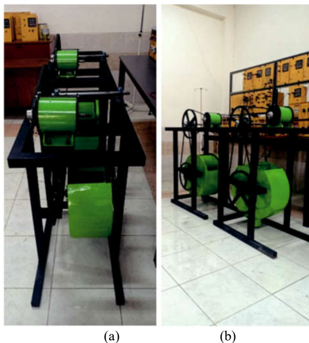
Gambar 8. Hasil perakitan turbin air, generator magnet permanen, pulley dan vanbelt yang menghubungkan turbin air dan generator (a) tampak depan dan (b) tampak samping.
