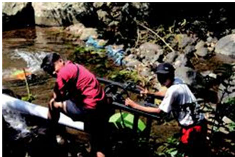
Gambar 10. Proses pemasangan pembangkit listrik tenaga pikohidro di lokasi Mitra (2)
