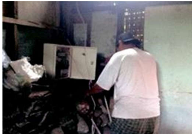
Gambar 13. Pemasangan panel kontrol di dalam rumah Mitra
