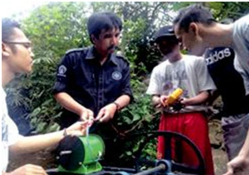
Gambar 12. Mengukur tegangan keluaran dari pembangkit listrik tenaga pikohidro.
