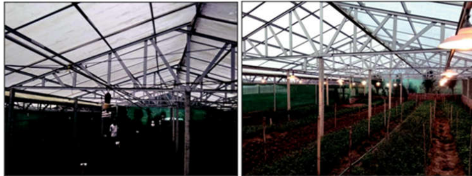
Gambar 6. Kondisi green house sebelum direvitalisasi (kiri) dan sesudah direvitalisasi (kanan)
