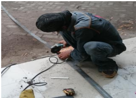
Gambar 11. Proses pemotongan bahan
