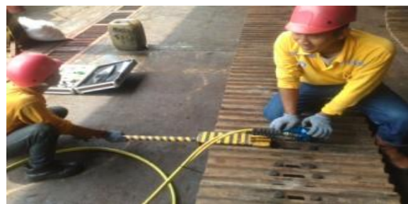
Gambar 15. Proses Penggantian Track Shoe Setelah Menggunakan Tool
