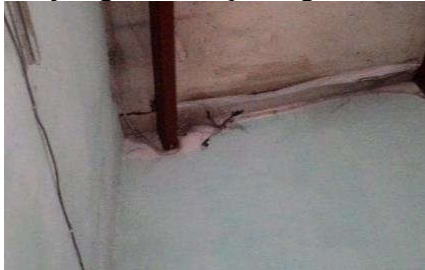
Gambar 3. Kontrakan nomer 1 milik H. Sarjiman yg berusia 17 tahun, percabangan kabel yang tidak berada di dalam kotak percabangan.
