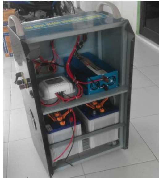
Gambar 4. Mesin Genset yang sudah dirakit
