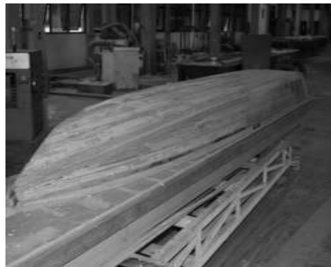
Gambar 1 pemasangan kayu laminasi pada frame
