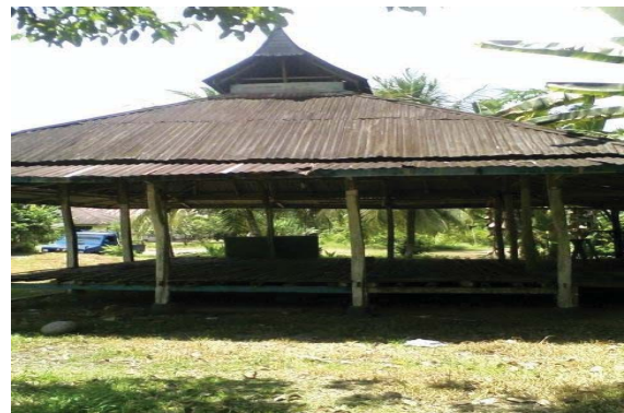
Gambar 6 Laga-laga permanen (Dokumentasi: Nurmalena, 2011)
