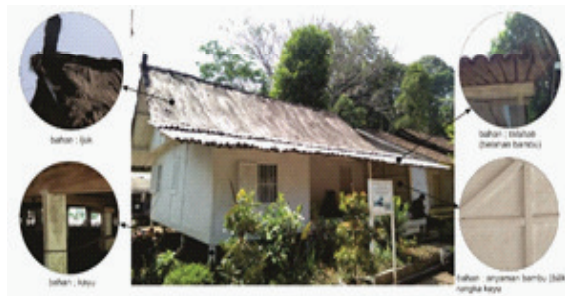
Gambar 9. Bahan/material bangunan rumah adat Kampung Pulo (Sumber: Sriwardani, 2019)
