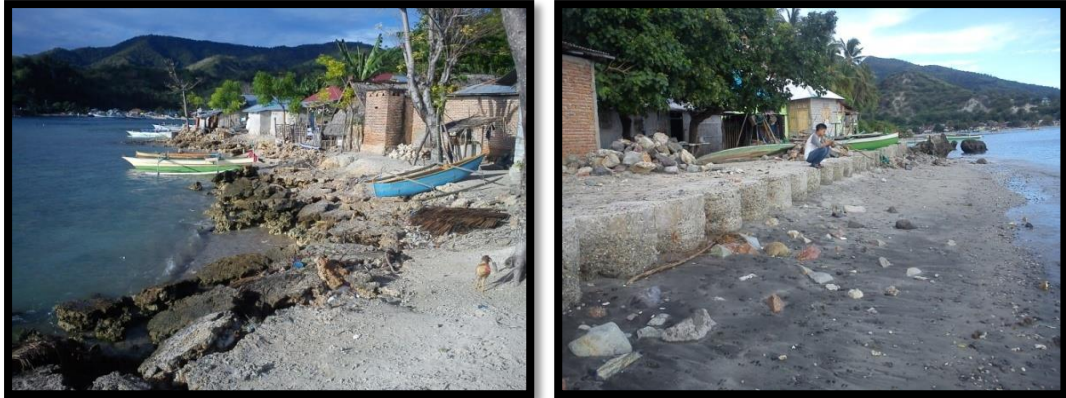
Gambar 7. Kondisi Bangunan yang ada di tepian pantai Sumber: Dokumentasi Pribadi, 2018
