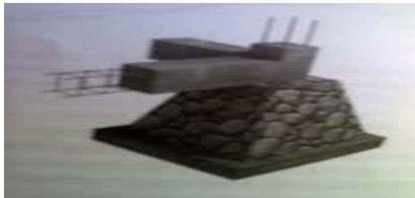
Gambar 4.14. Pondasi Umpak Sumber : Dokumen Pribadi
