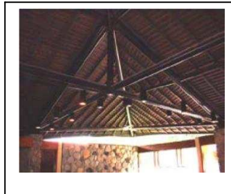
Gambar 5. Interior masjid An-Nur, Jatiluhur (1971-1972). Struktur rangka pipa dibiarkan telanjang, kejujuran struktur sebagai elemen interior.
